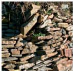
Degrado diffuso del coronamento, della base e di una parte superiore del muro
