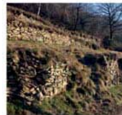
Crollo di parte di muro
